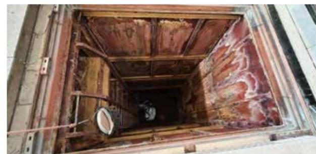
**Réfractaire** : divers travaux de maintenance du réfractaire du four et du 1<sup>er</sup> parcours : projection de béton sur la face droite de la voûte arrière, réparation du pied d'enfournement gauche, remplacement des briques manquantes par projection de béton, démolition et reconstruction par projection de béton de la voûte avant.
