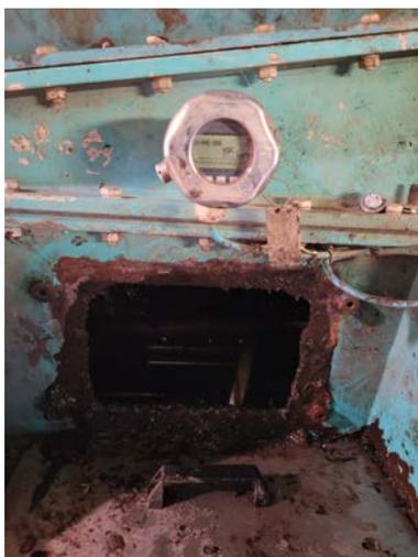
Un des deux débitmètres biogaz n'indique plus de valeur fiables (500 Nm<sup>3</sup>/H lorsque l'installation est à l'arrêt).
