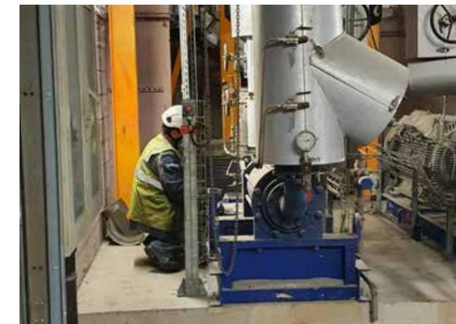
**Ballon chaudière** : modification des deux épingle du ballon chaudière par la pose de brides.
