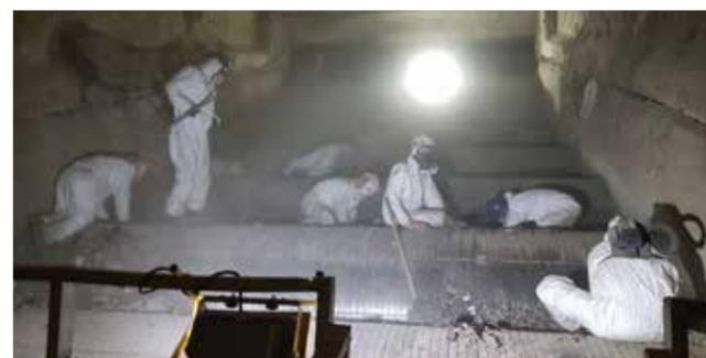
**Circuit vapeur et condensats** : travaux de réparation à la suite de différentes fuites (bride de la canalisation vapeur DN 250, doigt de gant de la tuyauterie du circuit d'eau alimentaire du ballon chaudière, bêche de récupération des condensats, bride en amont de la vanne de mise à l'évent).
