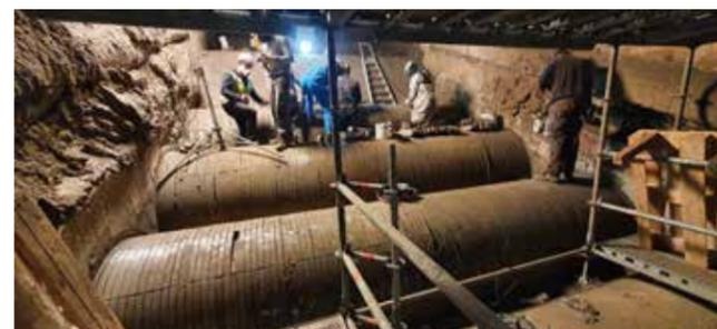
**Echangeur des fumées et gaines** : nettoyage à sec de l'échangeur.
