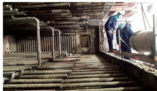
Le point critique du planning de cet arrêt technique sont les travaux de changement des surchauffeurs de la chaudière.
