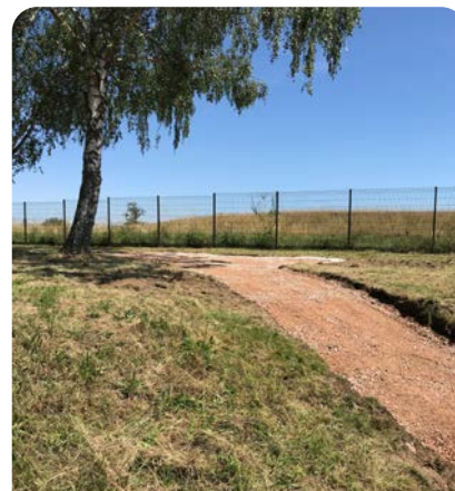
Terrassement pour l'installation du composteur
