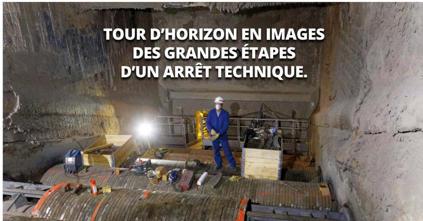
Vue intérieure du four avec ses 6 rouleaux rotatifs permettant de retourner les déchets pour optimiser la combustion. 21 tonnes de déchets sont incinérées toutes les heures
