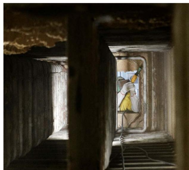
Sablage de l'intérieur de la chaudière afin d'éliminer les résidus de combustion
