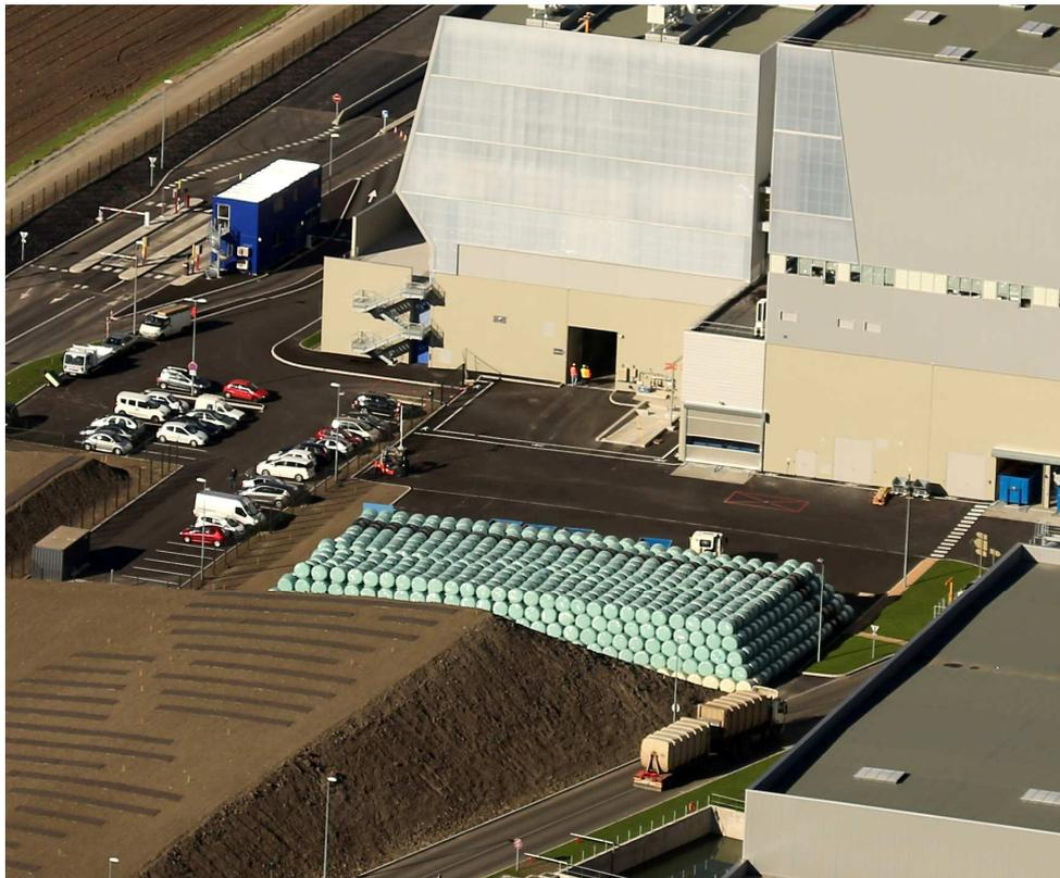
VERNEA dispose d'un équipement de mise en balle et d'une plateforme de stockage autorisée pour 3'700 tonnes et 4'080 balles pendant 6 mois maximum. Suite au démarrage des essais en août 2013, VERNEA a entrepris de réaliser des balles de déchets afin de constituer un stock pour garantir un apport de déchets linéaire pendant la phase d'essais de l'Unité de Valorisation Energétique (UVE).
